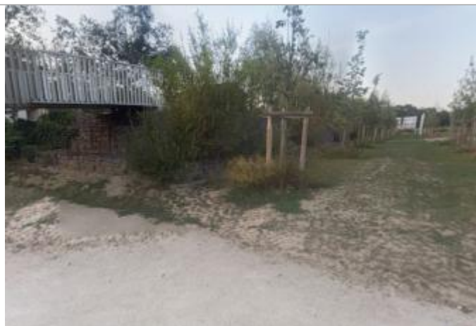
Gabions au niveau de la coulée verte (photo de Rod Rigue)
