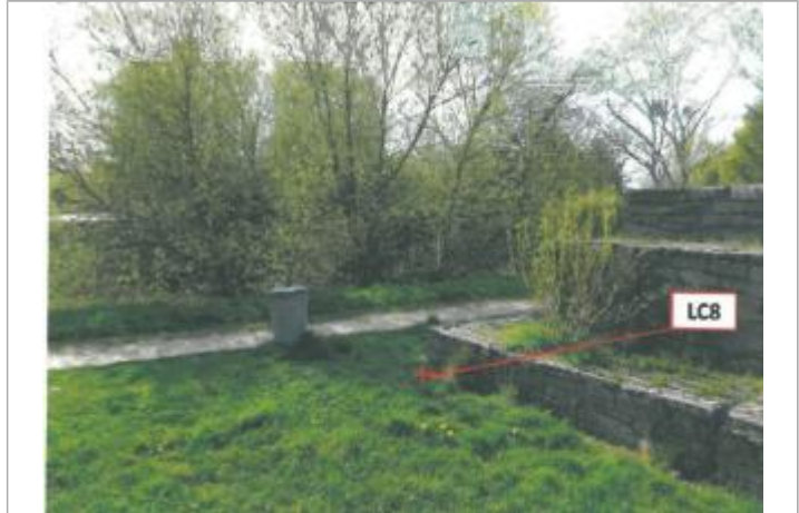
Digue en gabions support de la passerelle en 2013
