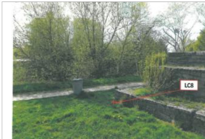
Digue en gabions support de la passerelle en 2013
