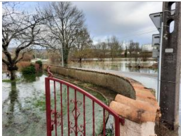
Poteau EDF à l'angle de la Grande Rue et la rue Gallot
