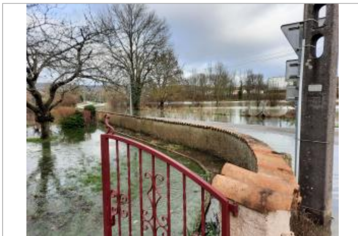
Poteau EDF à l'angle de la Grande Rue et la rue Gallot
