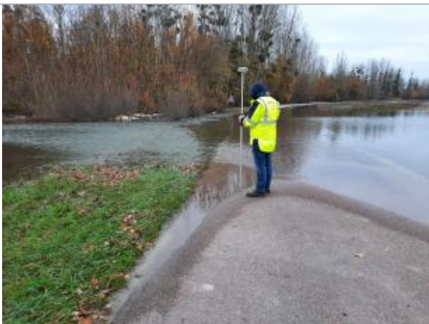
RD 136 entre Vaupoisson et Saint Nabord sur Aube
