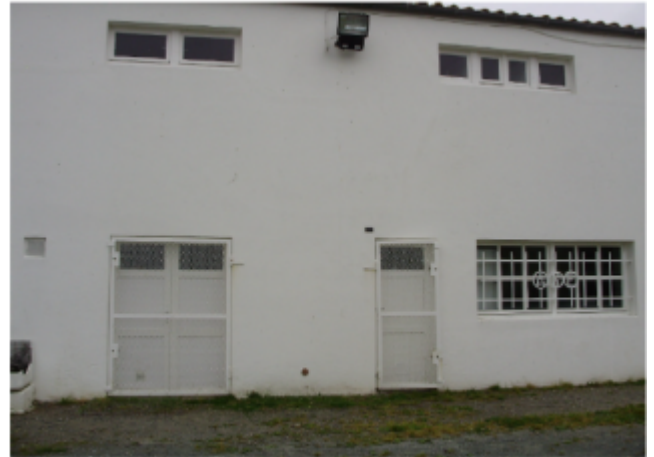
Repère et panneau sur le bâtiment du stade de foot d'Esnandes
