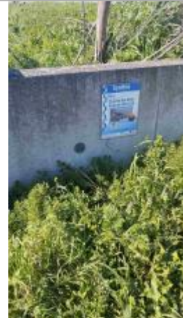
Repère et panneau sur le muret
