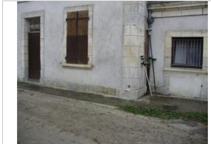
Repère et panneaux d'information présents sur la maison éclusière d'Andilly
