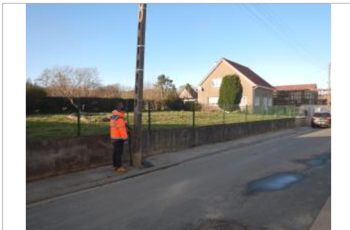
Le site est un poteau électrique
