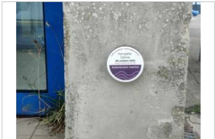
Repère de Submersion - Tempête Céline 28 octobre 2023
