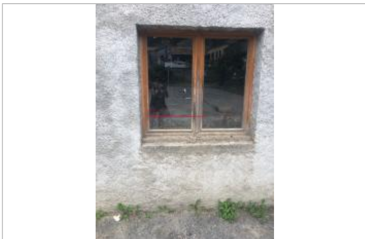
2023/05 - Fenêtre local technique
