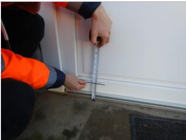
Le repère est situé sur la partie basse d'une porte.
