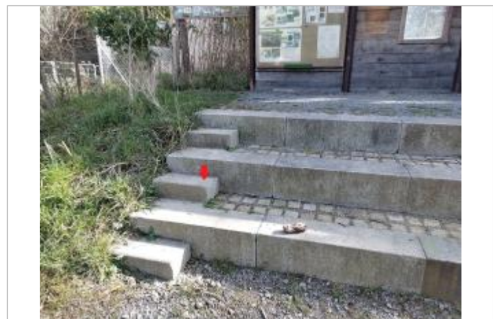
Marches de la maison (photo Rennes Métropole)
