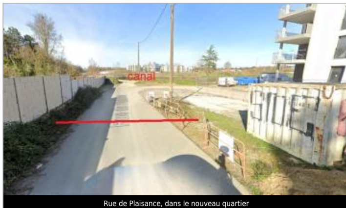
Rue de Plaisance, dans le nouveau quartier
