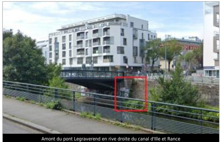
Amont du pont Legraverend en rive droite du canal d'Ille et Rance
