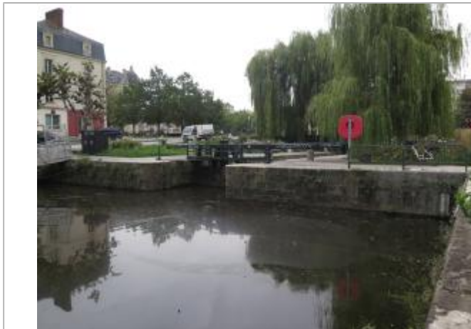
Ecluse du Mail à Rennes - échelle amont
