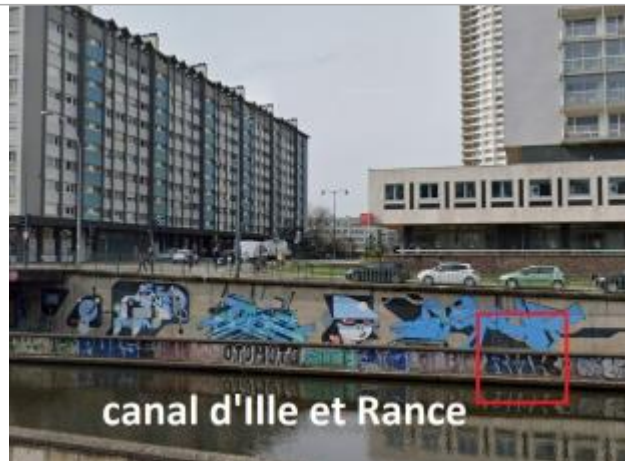
berge du canal d'Ille et Rance, rive droite face à l'immeuble Goelo
