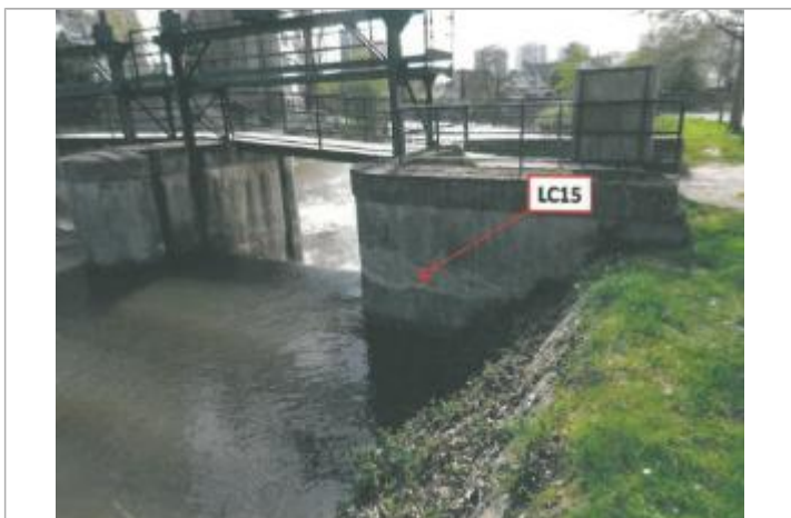
Pile amont rive droite du vannage Deslys
