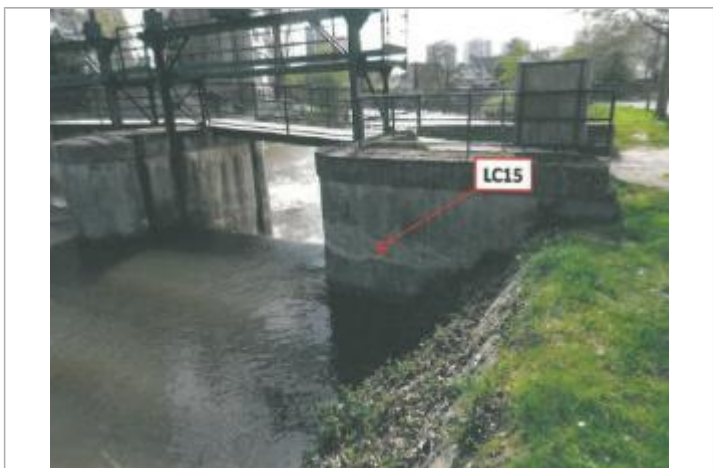
Pile amont rive droite du vannage Deslys
