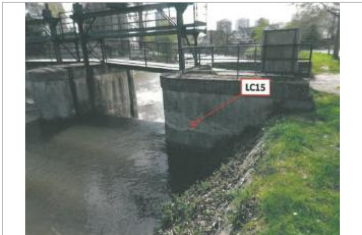
Amont vannage Deslys en 2013
