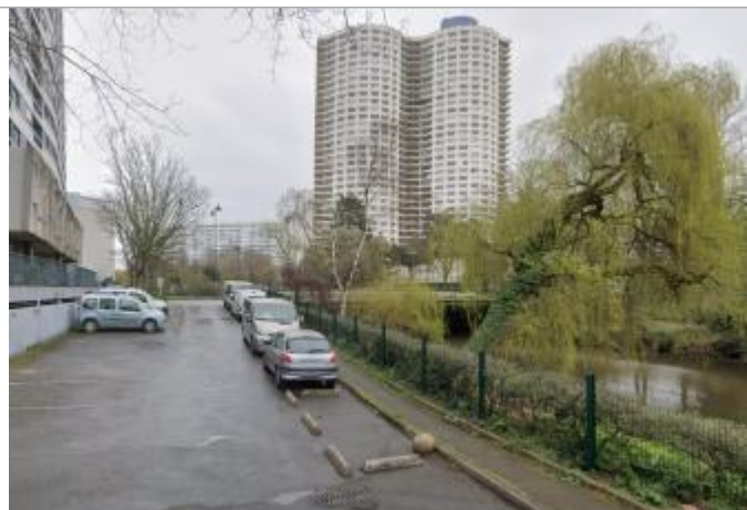
Allée Alfred Jarry en amont du pont de la rue de Brest
