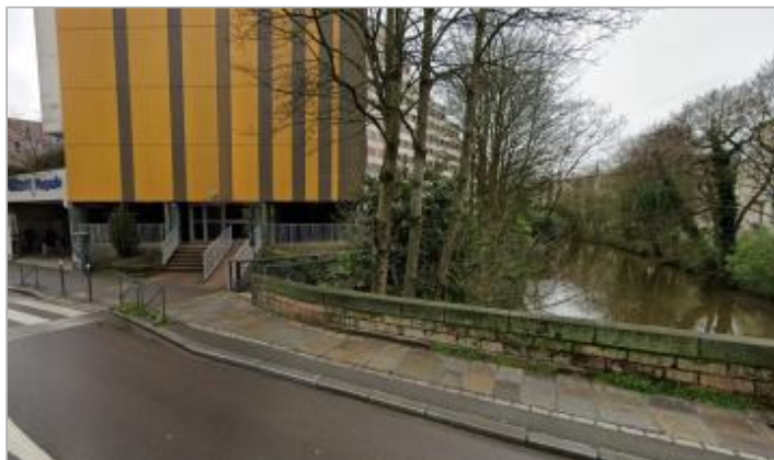
Sous le pont de la rue Vanneau - passerelle - derrière l'immeuble Trimaran
