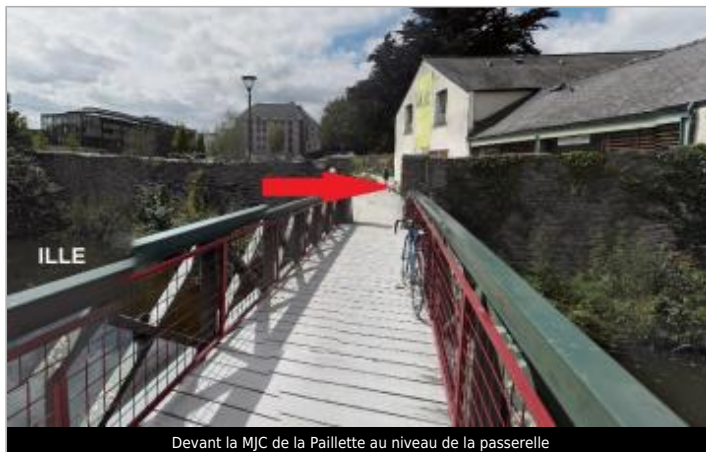
Devant la MJC de la Paillette au niveau de la passerelle
