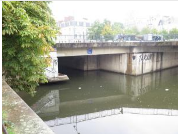
Confluence du canal d'Ille et Rance ( à gauche) et de la Vilaine (à droite)
