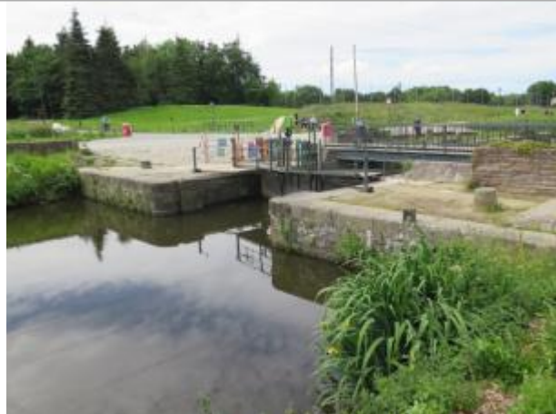
Vue générale de l'écluse du Comte Amont à Rennes
