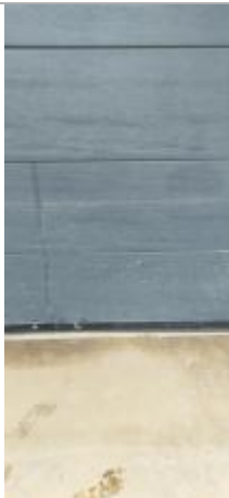
84 cm au dessus du seuil de la porte de garage
