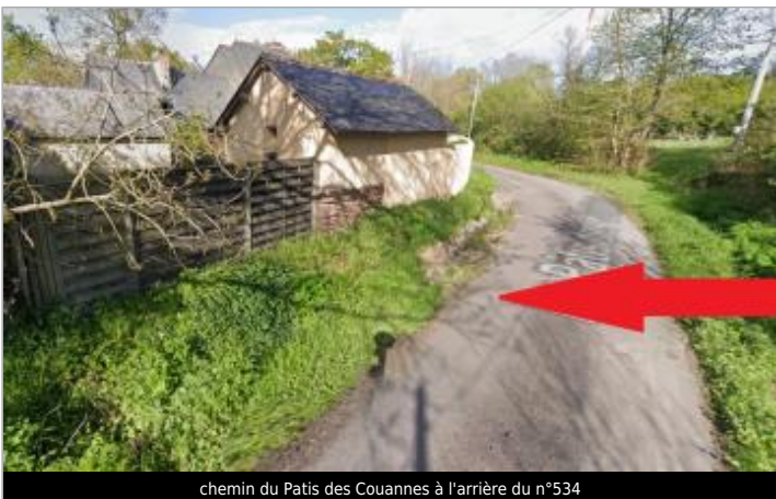
chemin du Patis des Couannes à l'arrière du n°534
