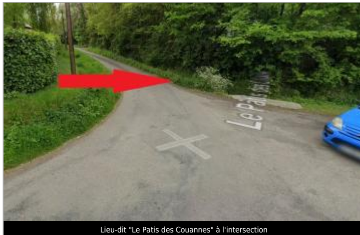
Lieu-dit "Le Patis des Couannes" à l'intersection
