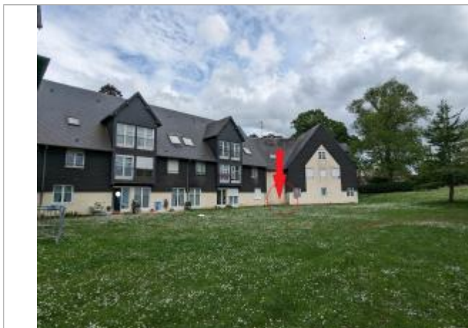
Vue depuis la cour à l'arrière du bâtiment.
