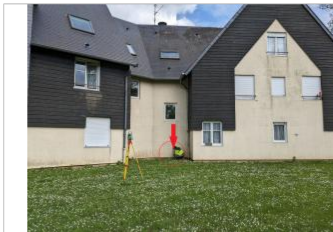
Laisse de crue à 22 cm/sol.
