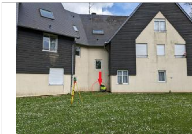
Laisse de crue à 22 cm/sol.
