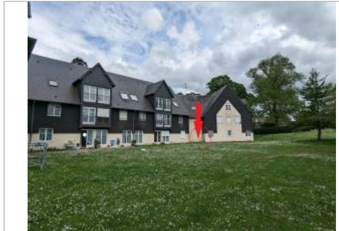
Vue depuis la cour à l'arrière du bâtiment.
