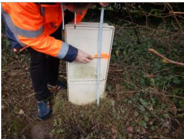
Le repère est sur le coffret électrique
