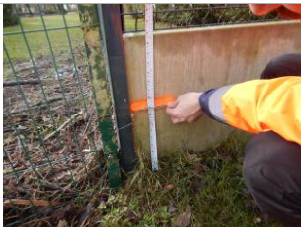
Le repère est au pieds du mur.
