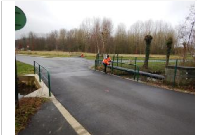
Le site est le garde-corps du pont sur la rue de l'étang
