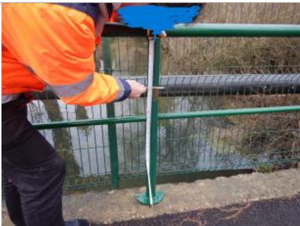
Le repère se trouve sur une rambarde.
