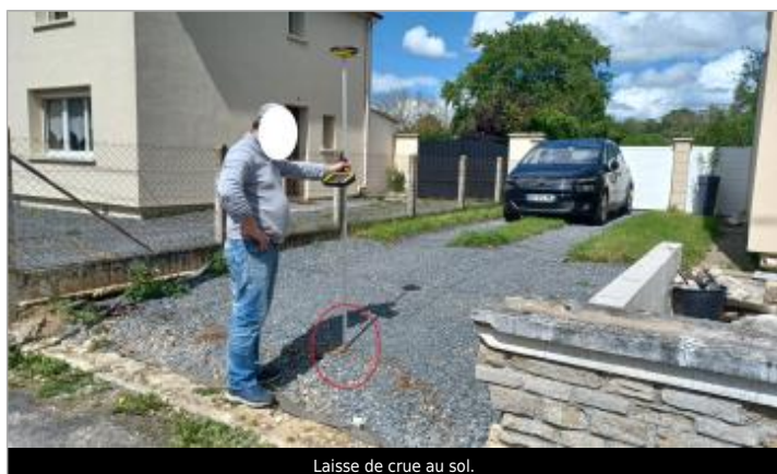
Laisse de crue au sol.
