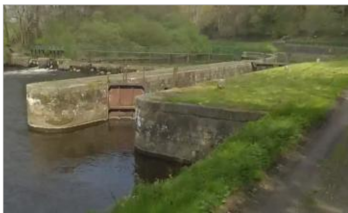
Bajoyer aval (échelle disparue) de l'écluse d'Auquinian
