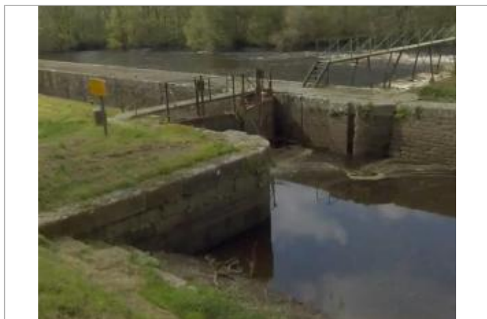
Bajoyer amont (échelle disparue) de l'écluse d'Auquian
