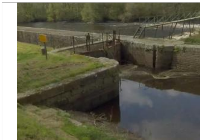
Bajoyer amont (échelle disparue) de l'écluse d'Auquinian
