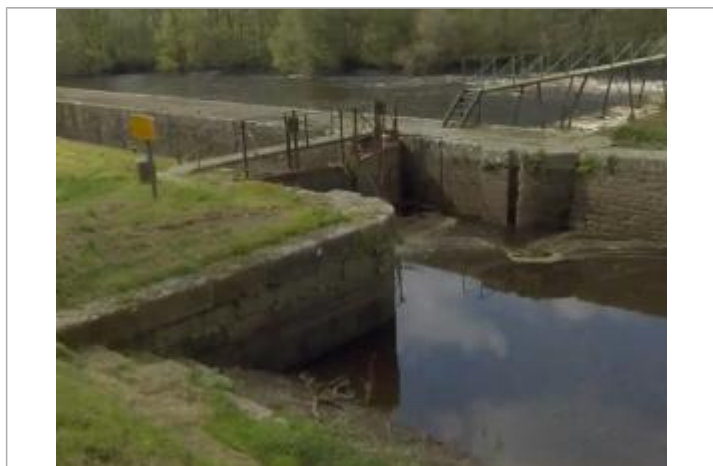
Bajoyer amont (échelle disparue) de l'écluse d'Auquinian
