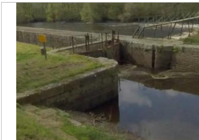
Bajoyer amont (échelle disparue) de l'écluse d'Auquinian
