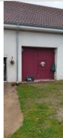
10 rue de la Vaux
