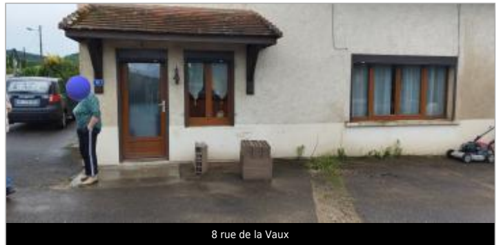
8 rue de la Vaux
