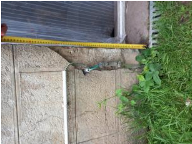
27 cm - Porte extérieure de la maison
