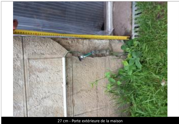
27 cm - Porte extérieure de la maison
