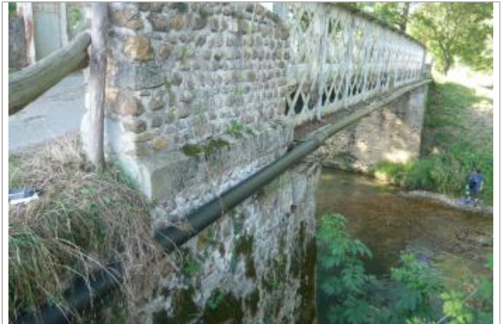
Pont de Clarac (65) sur l'Arros, vu coté amont
