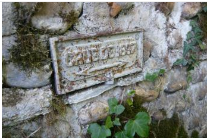
Plaque de la crue de 1897 sur culée amont, rive gauche
