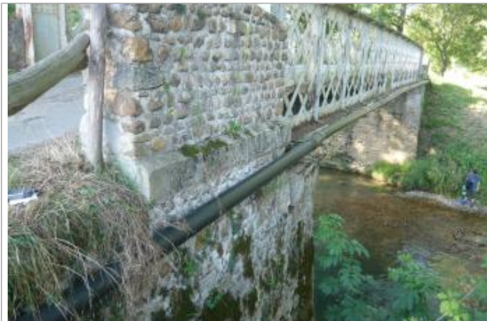
Pont de Clarac (65) sur l'Arros, vu coté amont
