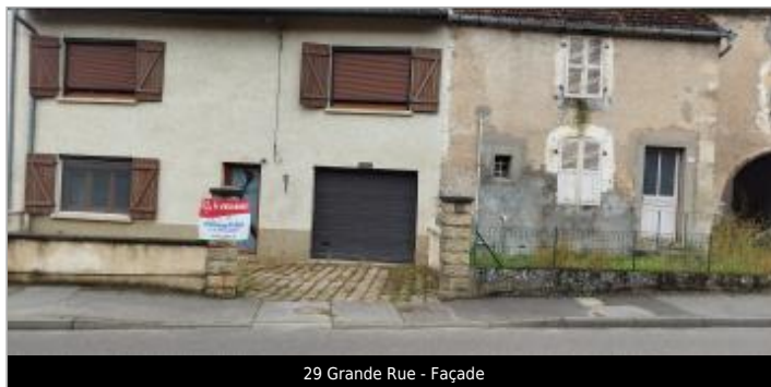
29 Grande Rue - Façade
