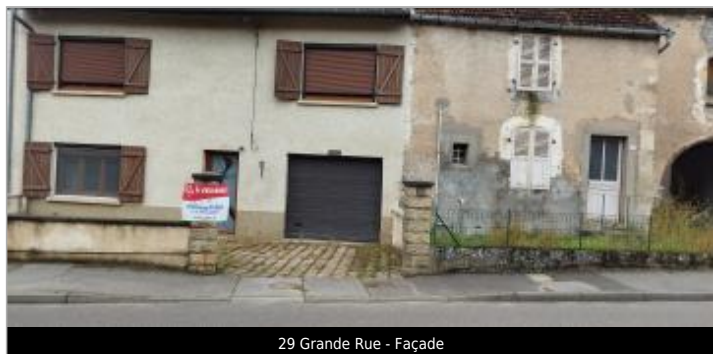
29 Grande Rue - Façade
