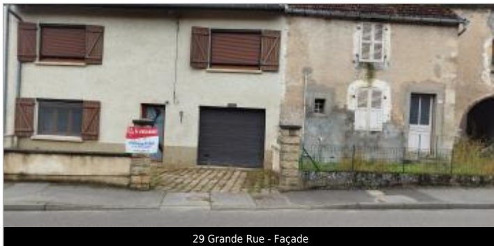
29 Grande Rue - Façade
