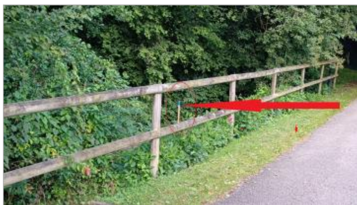
Laisse de crue au sol
