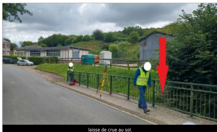
laisse de crue au sol.
