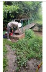
Mesure faite sur la passerelle avec référence altitude sur le support en briques
