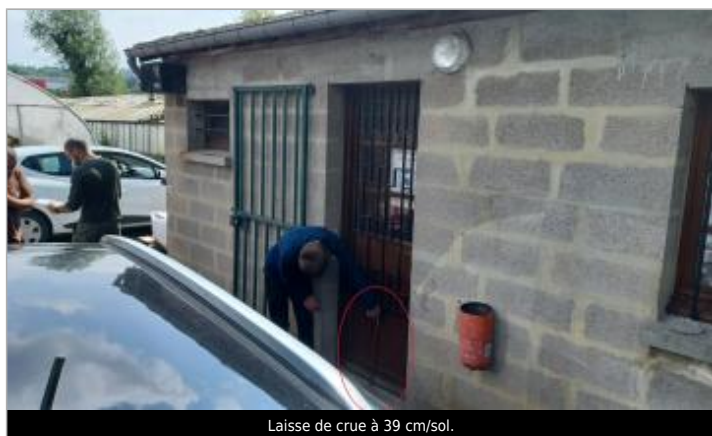
Laisse de crue à 39 cm/sol.
