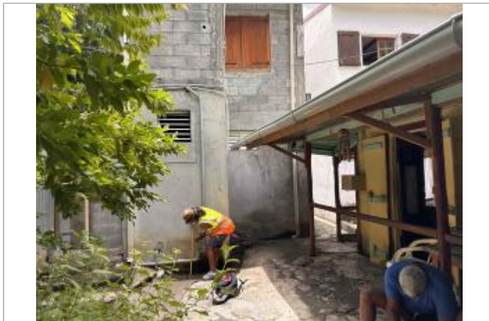
Témoignage d'une hauteur d'eau
