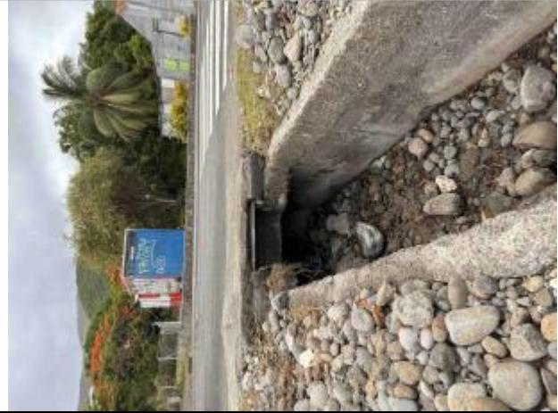
Inondation jusque sur la route et buse encombrée par des dépôts (galets, sables)
