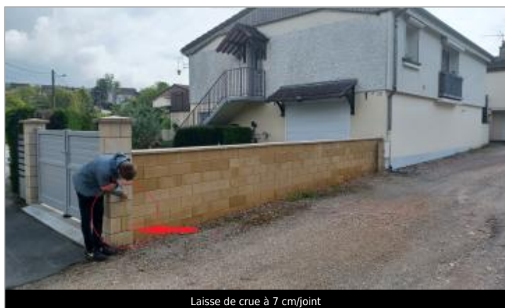
Laisse de crue à 7 cm/joint
